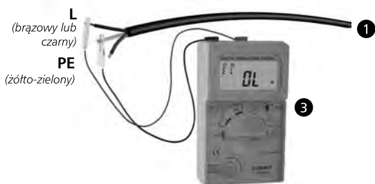
Pomiar rezystancji izolacji
